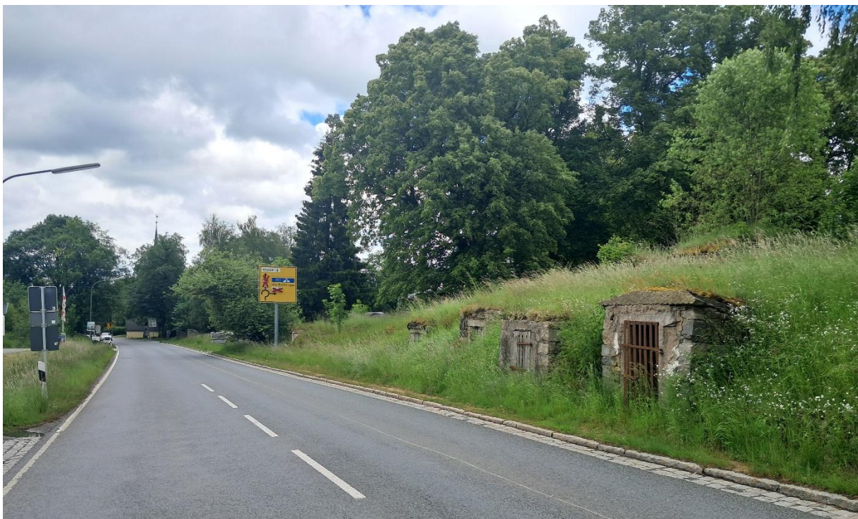
Ansicht Bayreuther Straße mit Blickrichtung Kellerhaus, Aufnahme: Stadt Bad Weißenstadt
