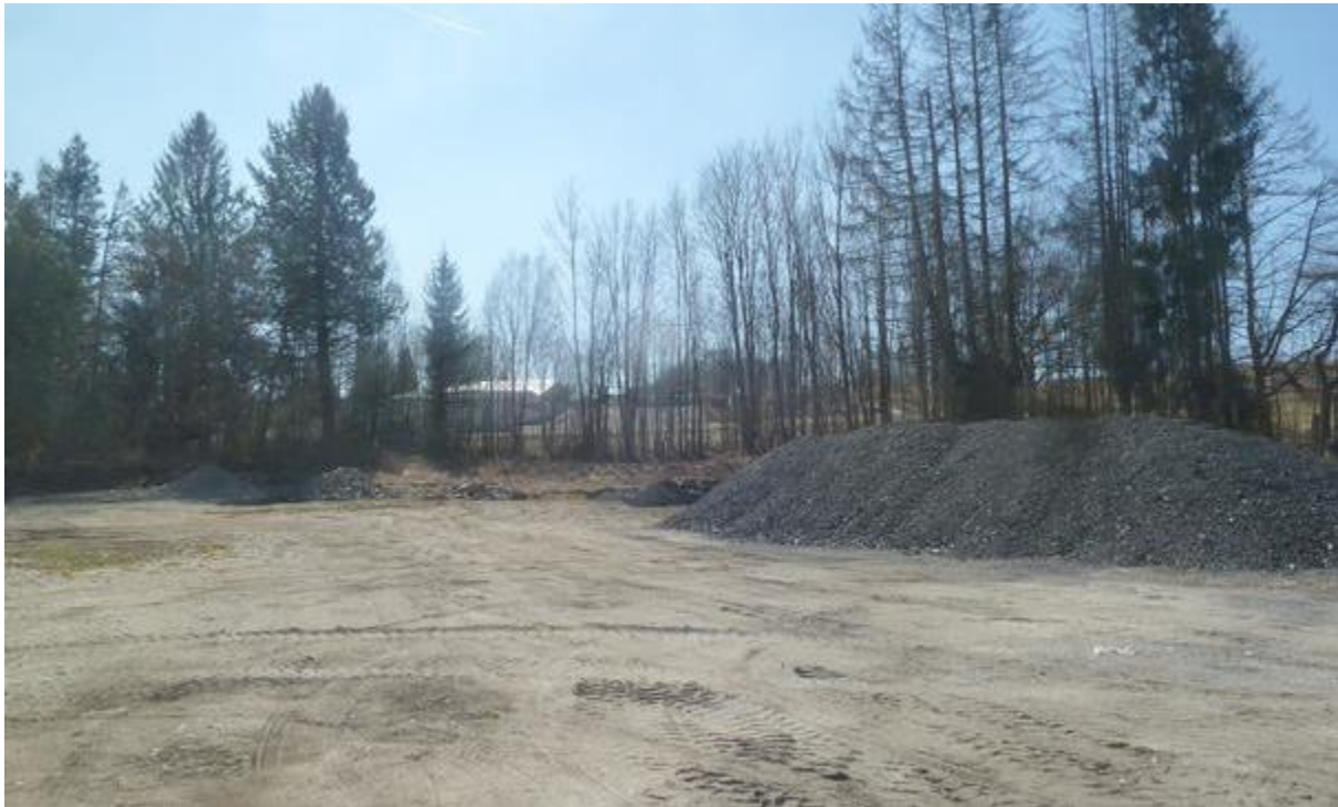
Abbildung 14: Baufeld auf der Fläche der ehem. Pelzfabrik
