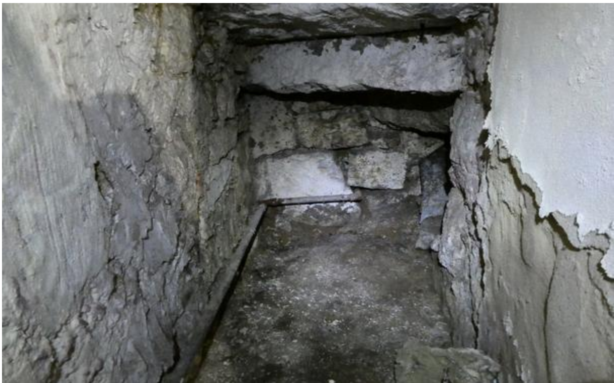
Abbildung 35: Nische unter der Kellertreppe
