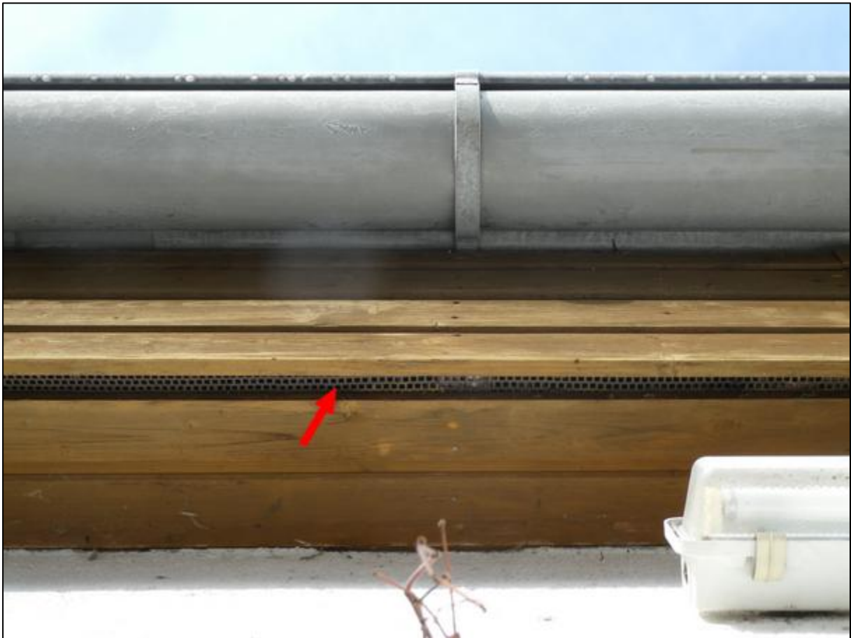
Abbildung 58: Dachtrauf; die Fugen sind mit Siebblechen verschlossen
