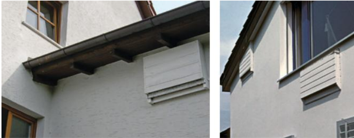
Abbildung 6: Beispiele für die Platzierung von Fledermauskästen an einer Fassade (Bildquelle: LfU, 2015, Seite 19)
