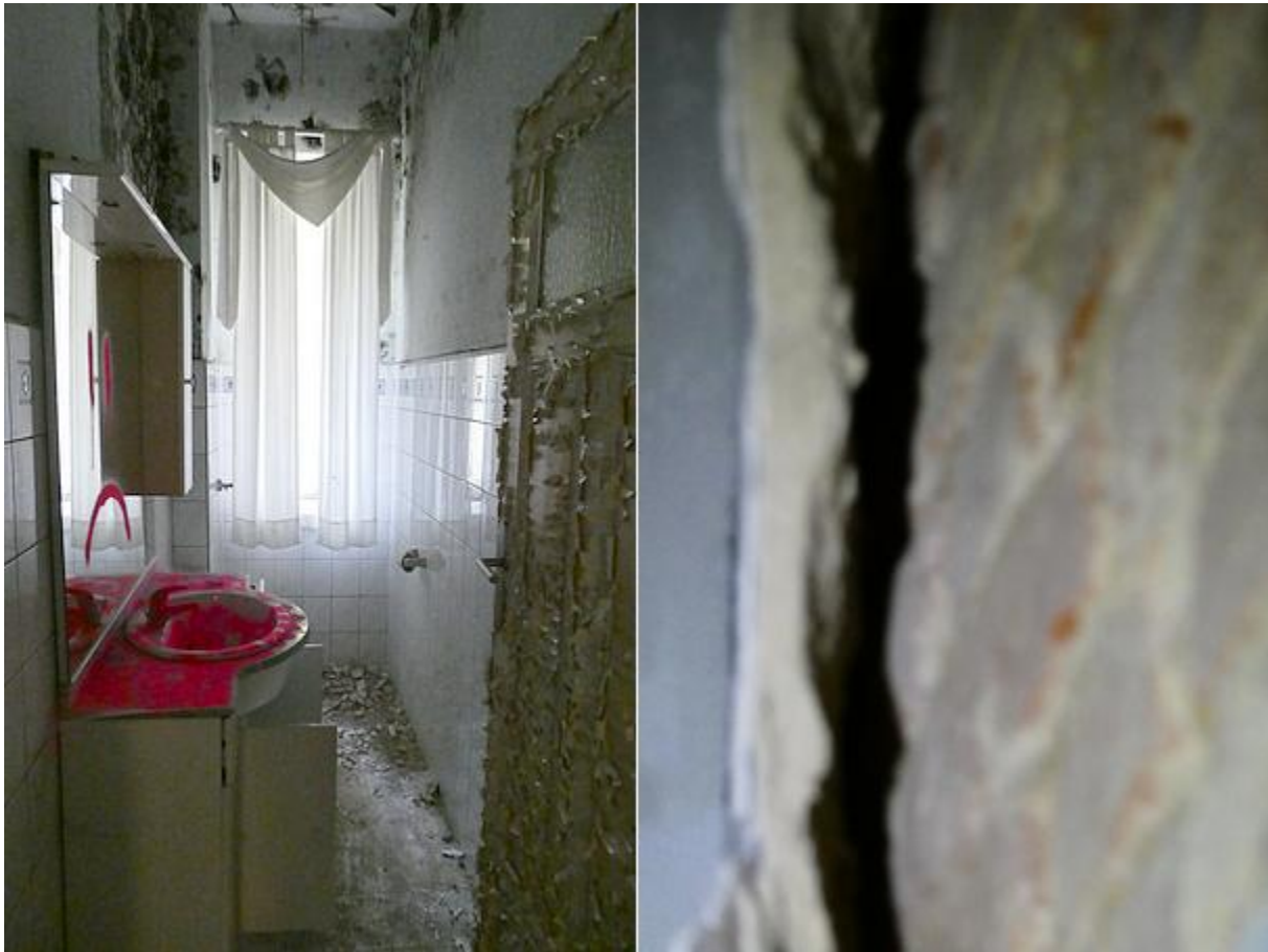
Abbildung 44: Feuchtraum im EG mit Zustand der Wand
