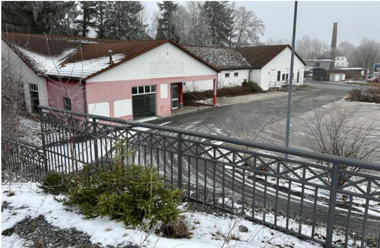
Abbildung 54: Gebäude, von der Bergstraße (Süden) aus betrachtet.
