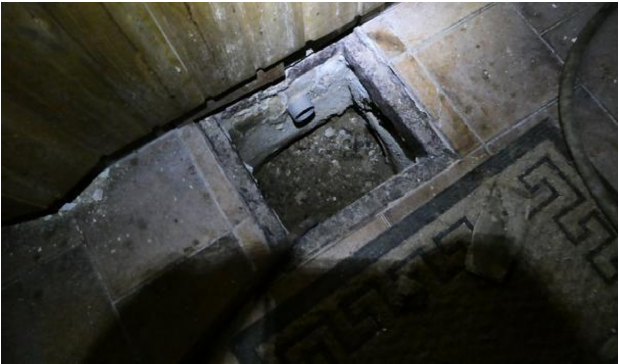
Abbildung 36: Entwässerungsschacht Keller
