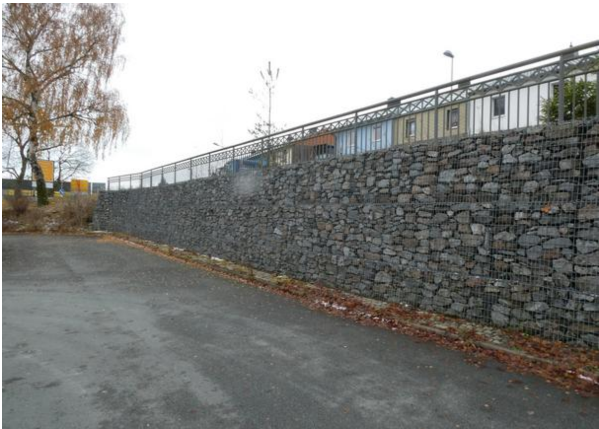
Abbildung 57: Gabionen-Mauer am Südrand zur Bergstraße hin
