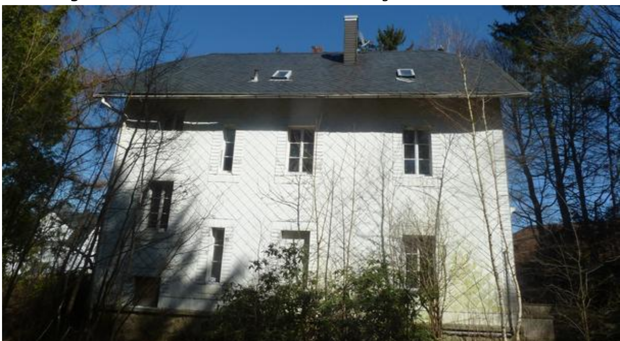
Abbildung 33: Gebäude aus südwestlicher Blickrichtung
