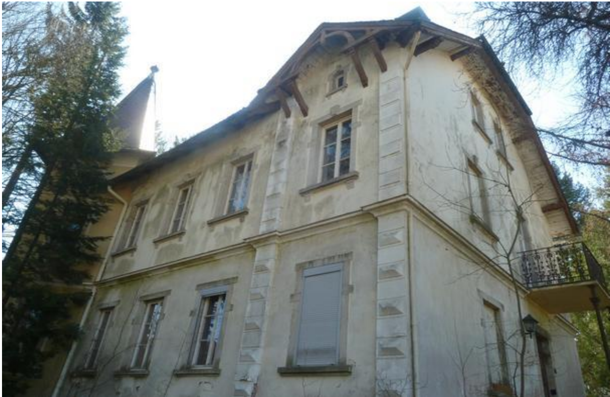
Abbildung 32: Gebäude aus nordöstlicher Blickrichtung
