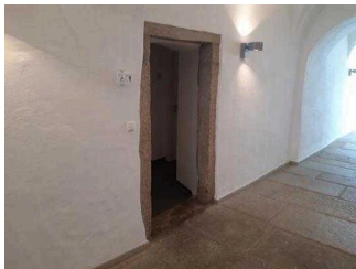
Durchgang zum WC (92 cm)
