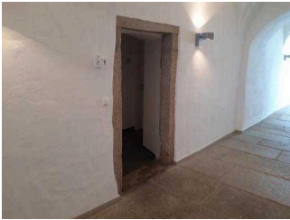
Durchgang zum WC (92 cm)
