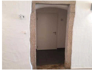
Durchgang / Tür zum WC
