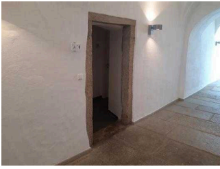
Durchgang zum WC (92 cm)
