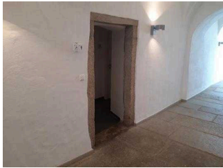
Durchgang zum WC (92 cm)
