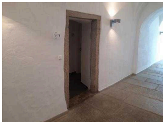
Durchgang zum WC (92 cm)
