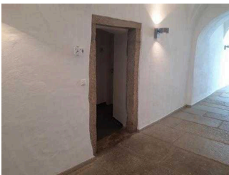
Durchgang zum WC (92 cm)
