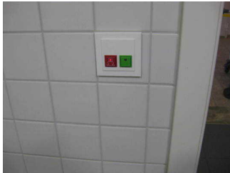
Alarmknopf an der Tür zum WC
