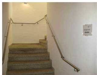
Treppe von unten
