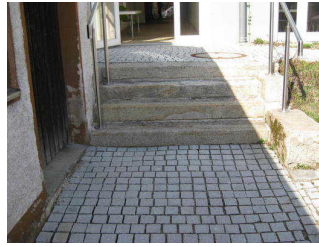
Treppe am Hintereingang
