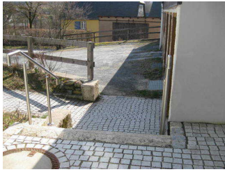
Treppe am Hintereingang
